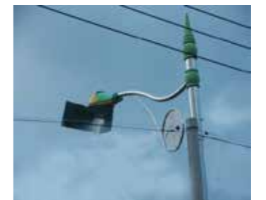
빔공해로 인한 가림막이 설치된 가로등
