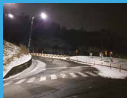
▶ 스노우멜팅 시공 현장 발열량 테스트
